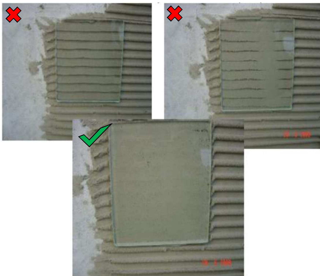
Imagem 37 – Maneiras incorretas e corretas de assentar as peças cerâmicas
